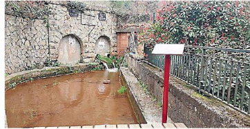
L'aménagement a été complété par la pose d'une plaque signalétique.
