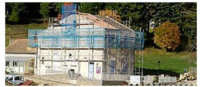
La nouvelle toiture bientôt terminée.
