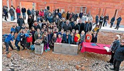
■ La construction de l'établissement est déjà bien avancée.
