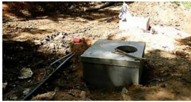
Les chambres de captage sont neuves.
