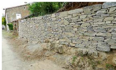
Une construction sans mortier, tout en pierres sèches.
